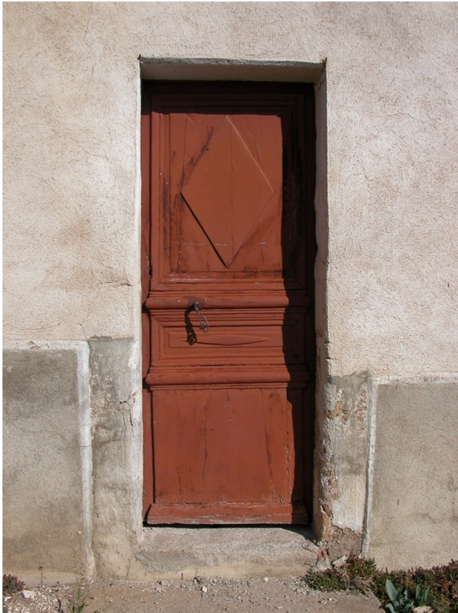
Détail de la porte du logis.
