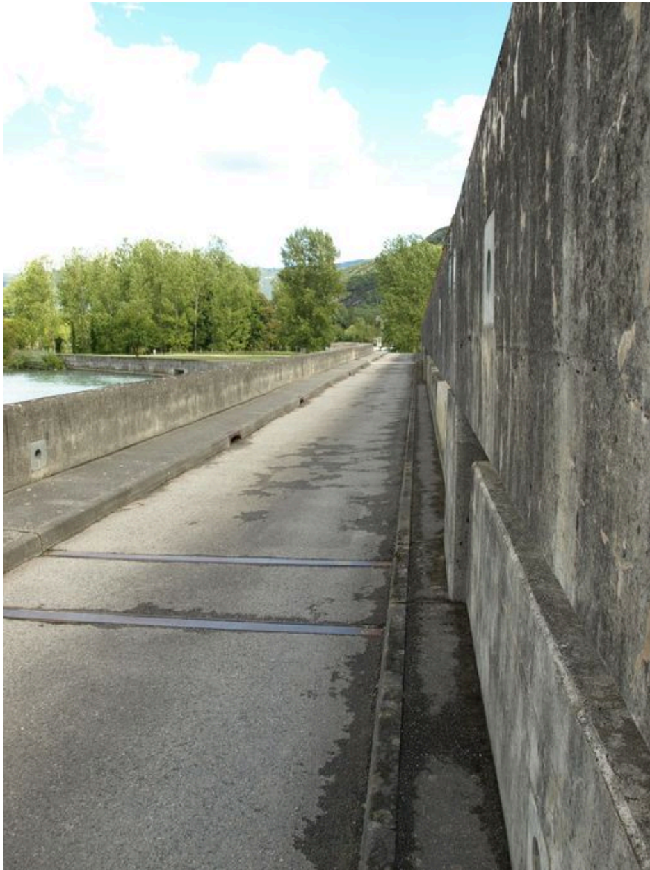
Pont, vue de la chaussée
