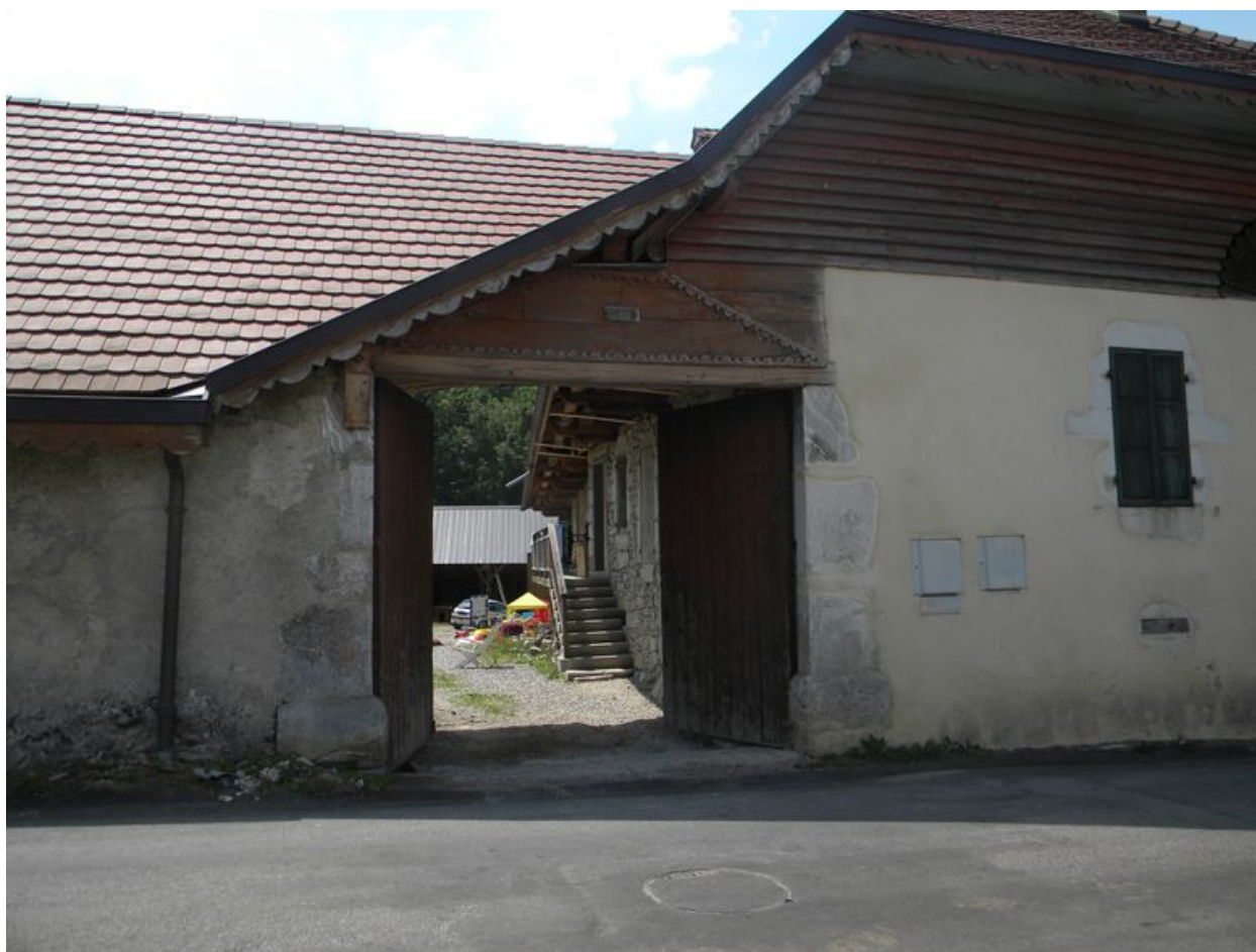
Vue du porche d'entrée formé par la proximité d'un dépendance en face est.
