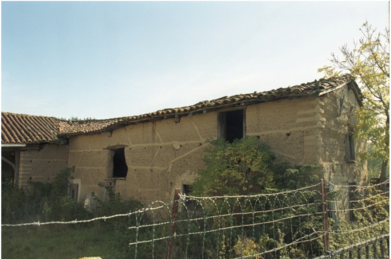
Saint-Sixte, Thay (1987 D2 261), type A1. Vue d'ensemble des communs.
