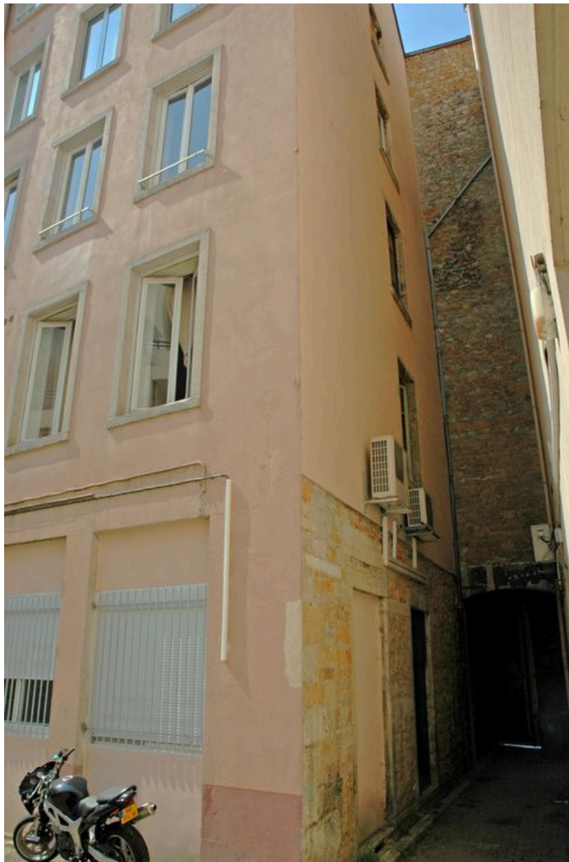
Vue de 3/4 nord-ouest et du passage du 95 Grande rue de la Guillotière
