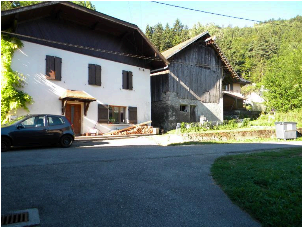
Vue d'ensemble d'une ferme et d'une grange (2008 D4 881, 882).
