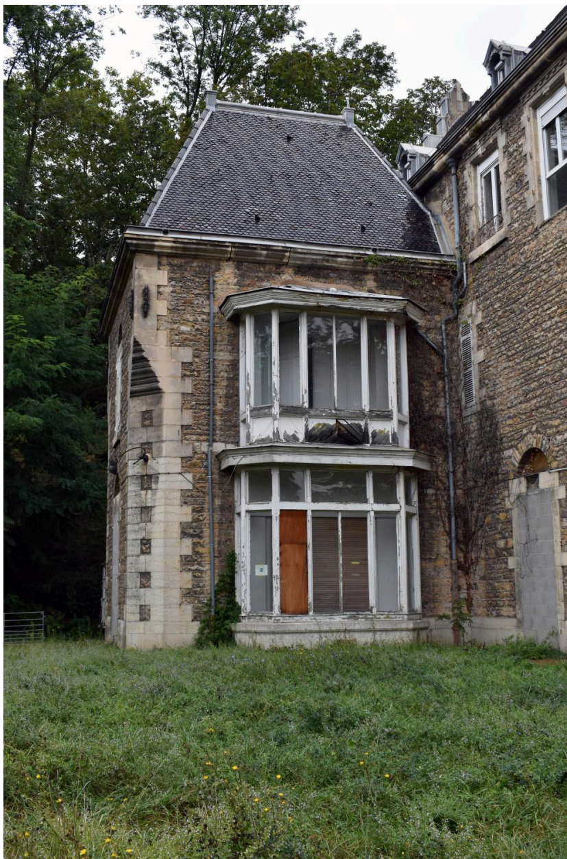
Pavillon sud, vue d'ensemble depuis le sud-est
