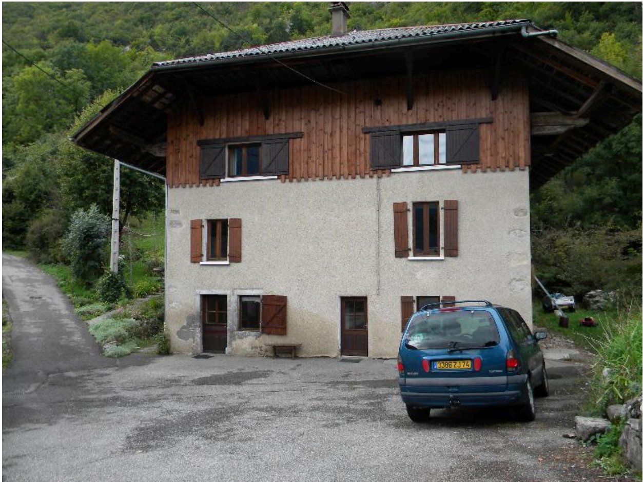
Vue du mur pignon d'une ancienne ferme (2008 C3 300)
