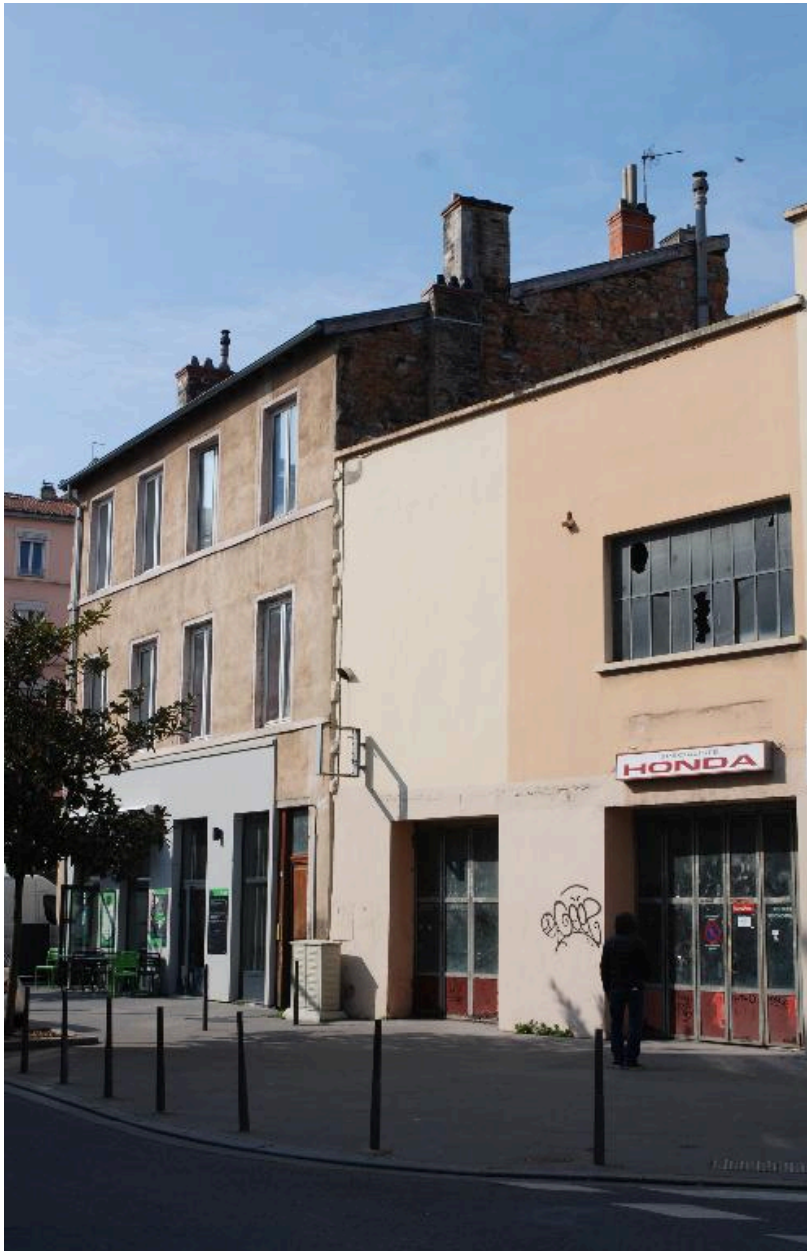
Vue latérale nord, montrant la toiture à un pan et le pignon en moellons apparents
