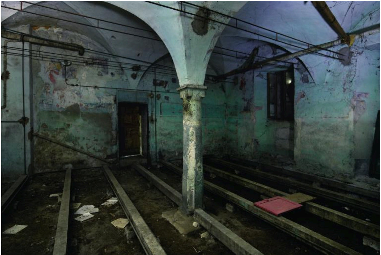
Vue d'ensemble de la chapelle
