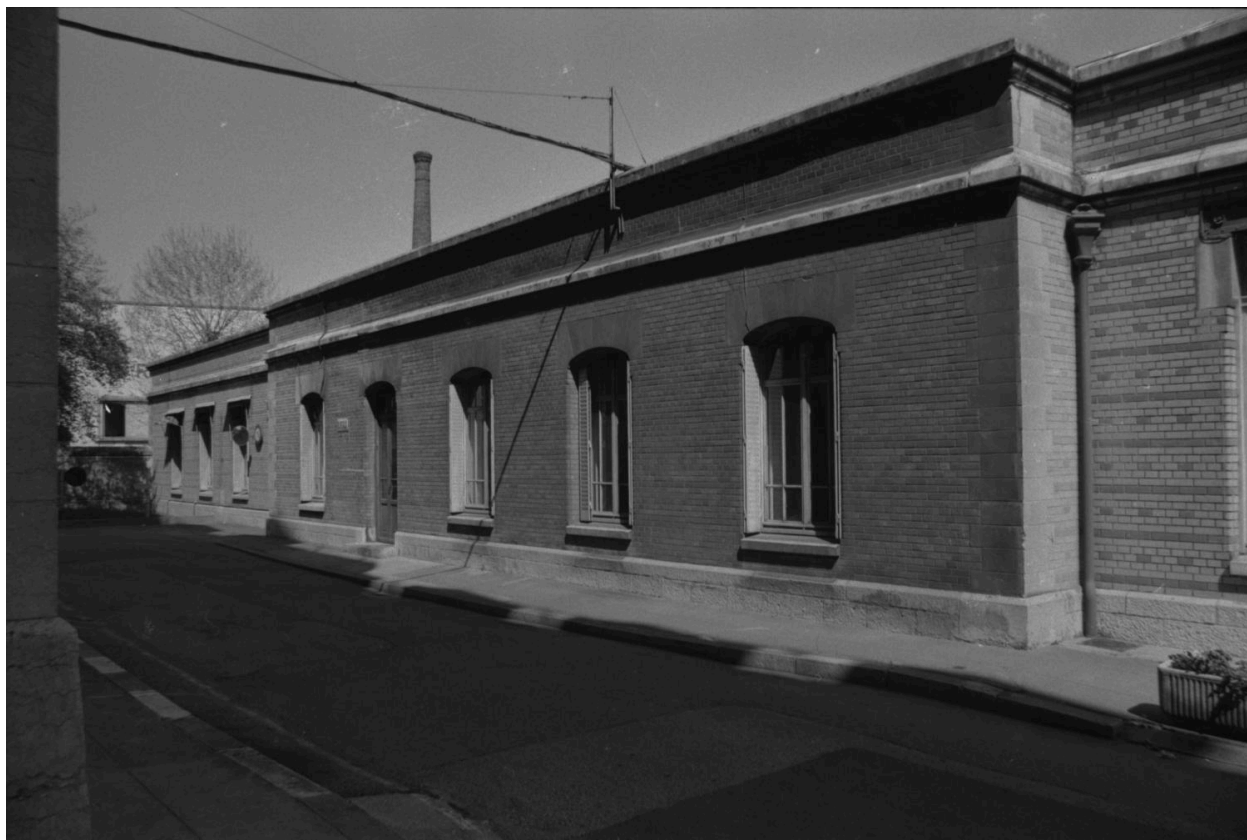
Bâtiment 1 (bureaux), façade ouest
