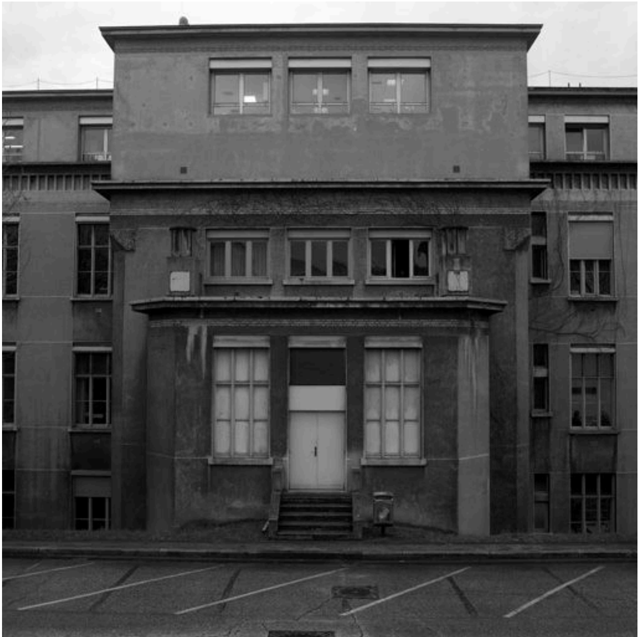
Le pavillon E : entrée principale de l'élévation nord
