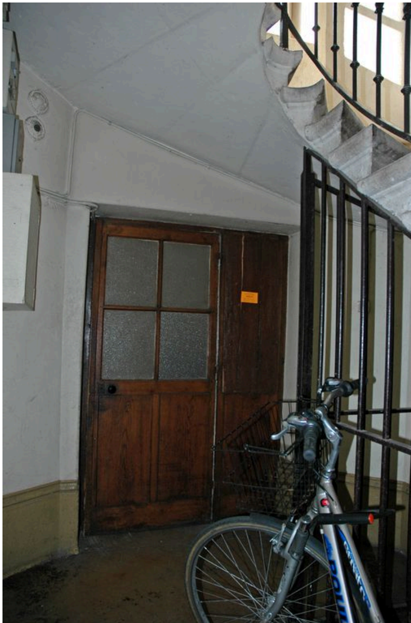
Entrée de la loge de concierge sous l'escalier
