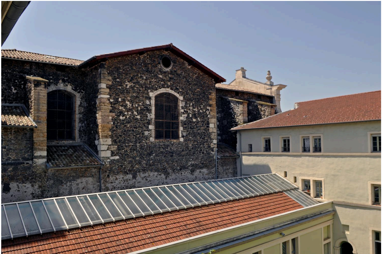
Élévation nord, vue depuis le nord-est
