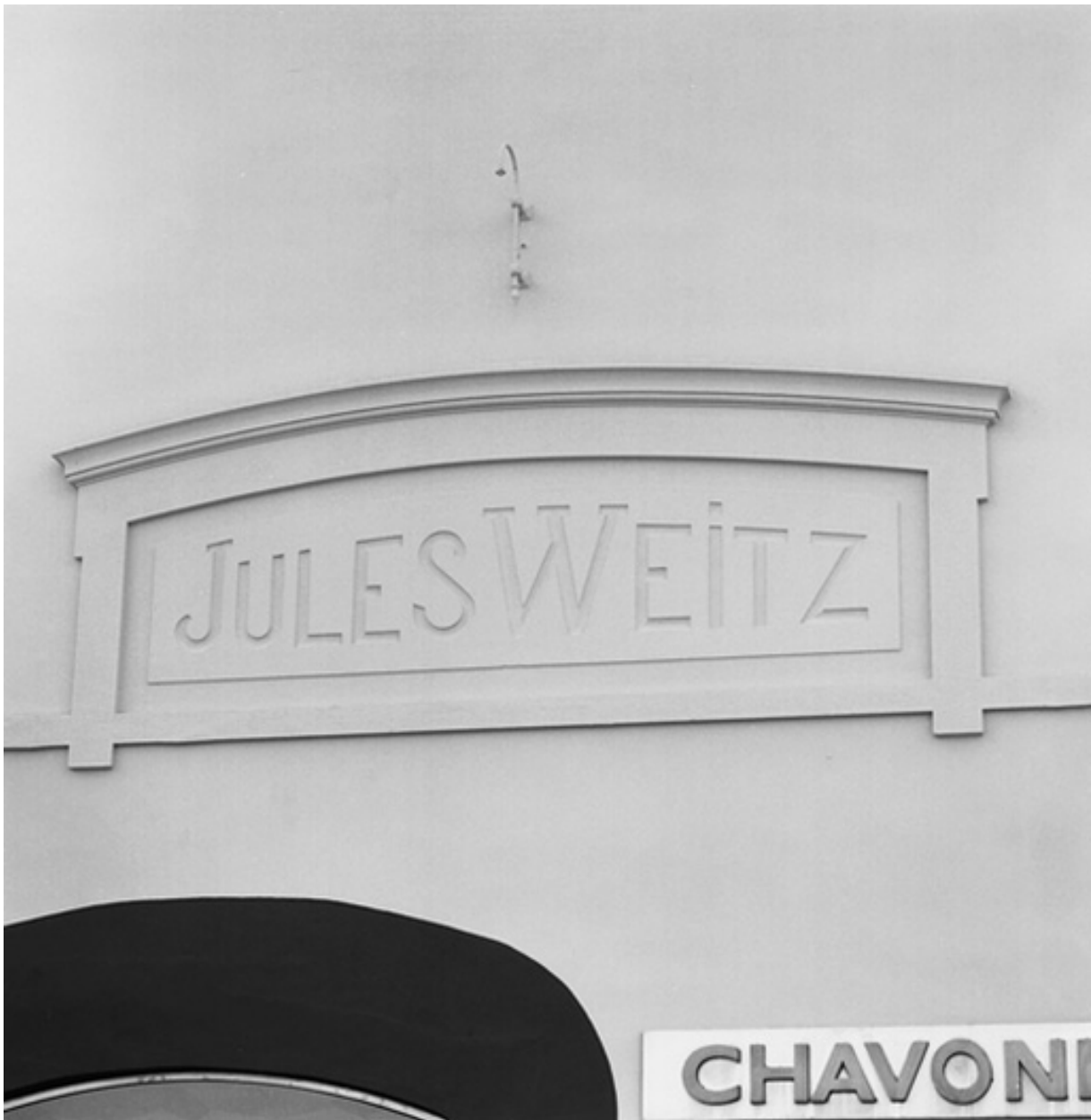
Détail façade enseigne
