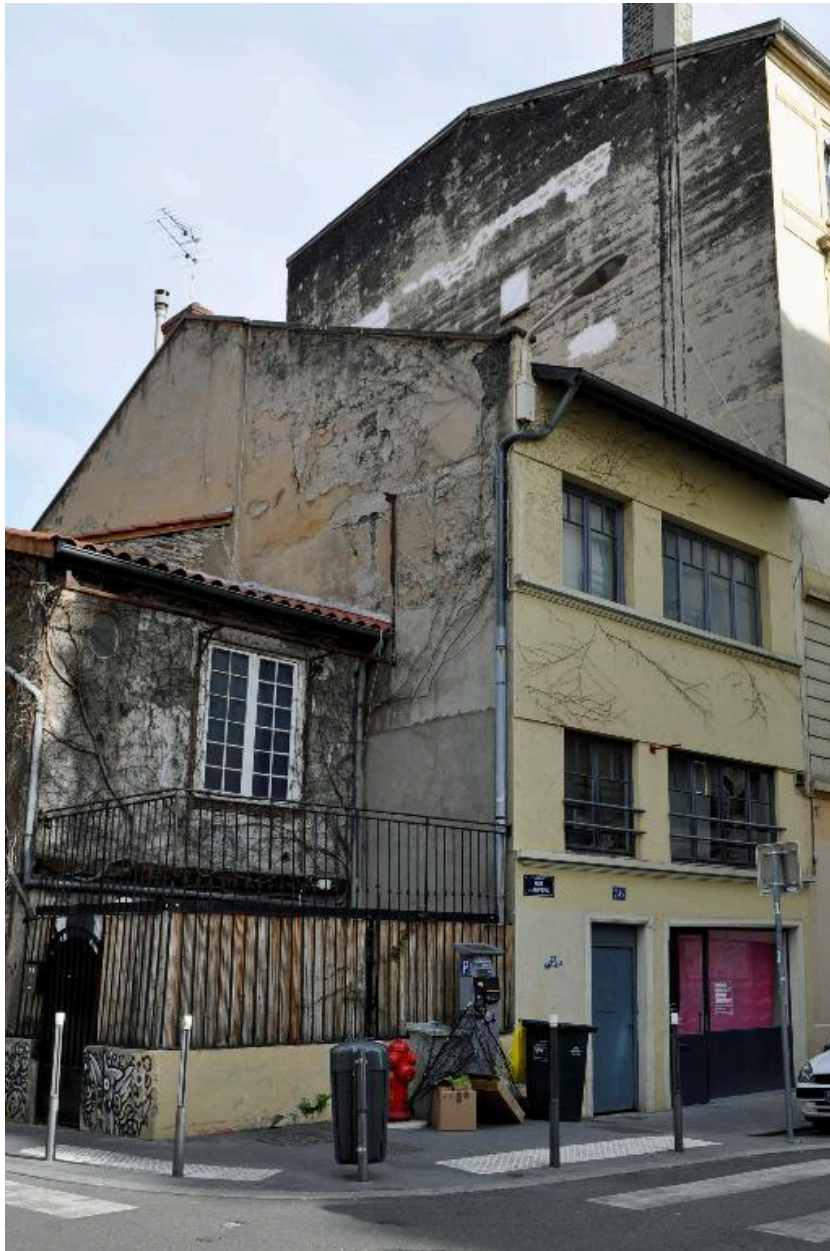
Vue générale, prise depuis le sud
