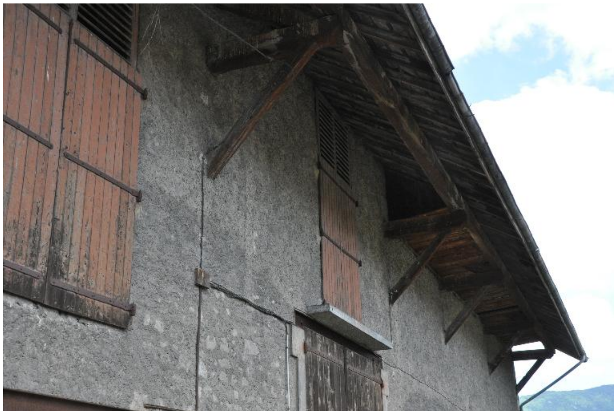
Détail des aisseliers soutenant l'avant-toit
