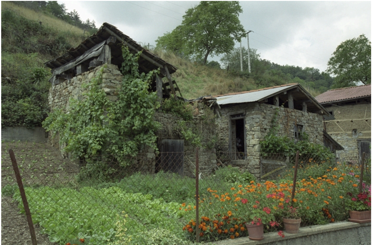
Saint-Laurent-Rochefort, Rivier (1987 A3 1747), type B1. Vue d'ensemble du fournil.
