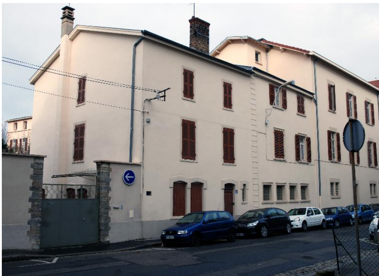
Bâtiments rue Henri Gorjus, vue rapprochée
