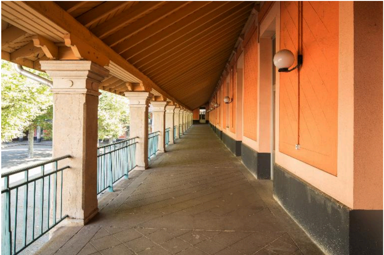
Galerie couverte au premier étage
