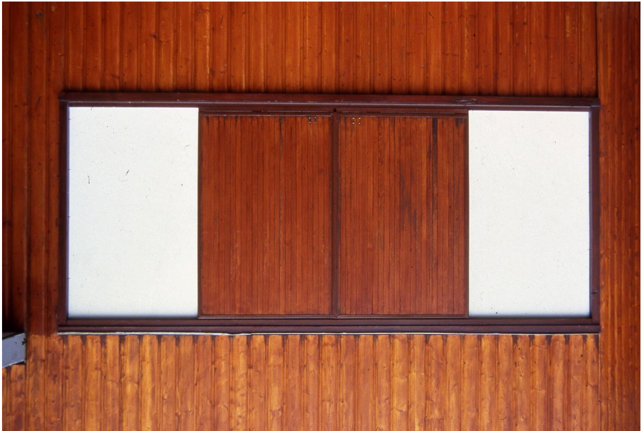
Détail des baies de l'élévation nord
