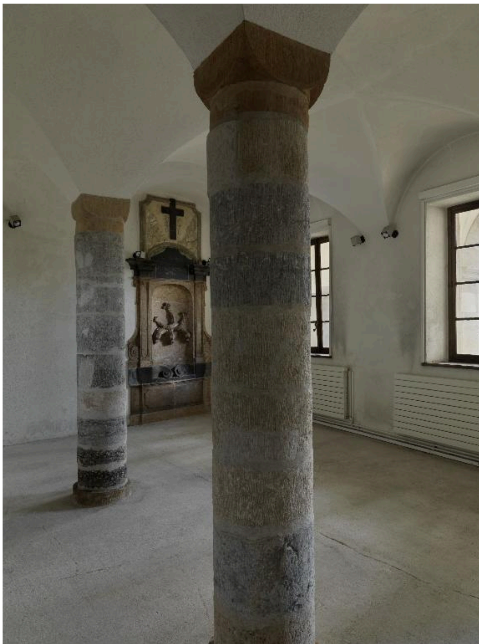
Ancienne dépense au rez-de-chaussée : vue d'une colonne et fontaine en remploi
