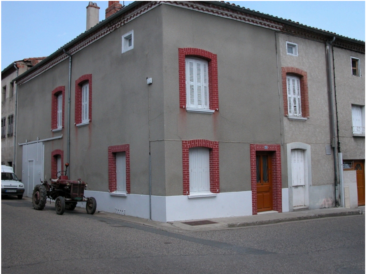
Faubourg du Chauffour, rue de la Mairie (1999 AD 58). Maison, ferme.
