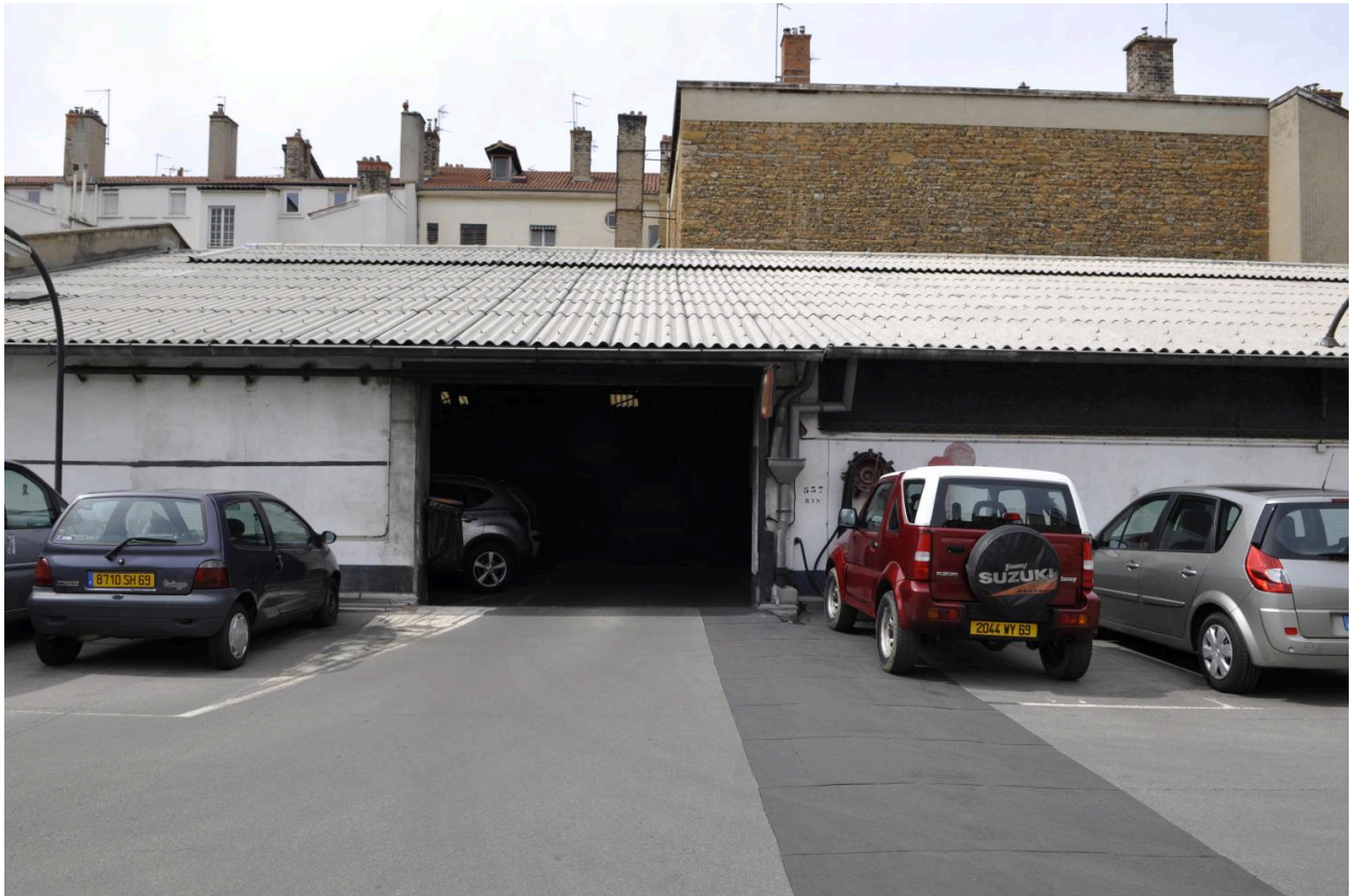
Entrée et sortie du parking souterrain menant au parking extérieur
