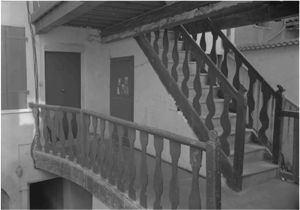
40 Grande rue : cage d'escalier dans la cour.
