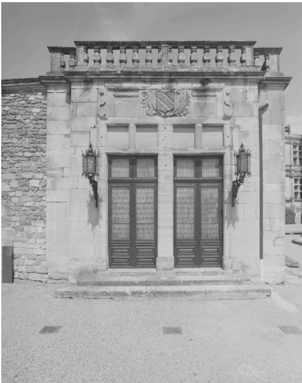
Galerie. La façade ouest.
