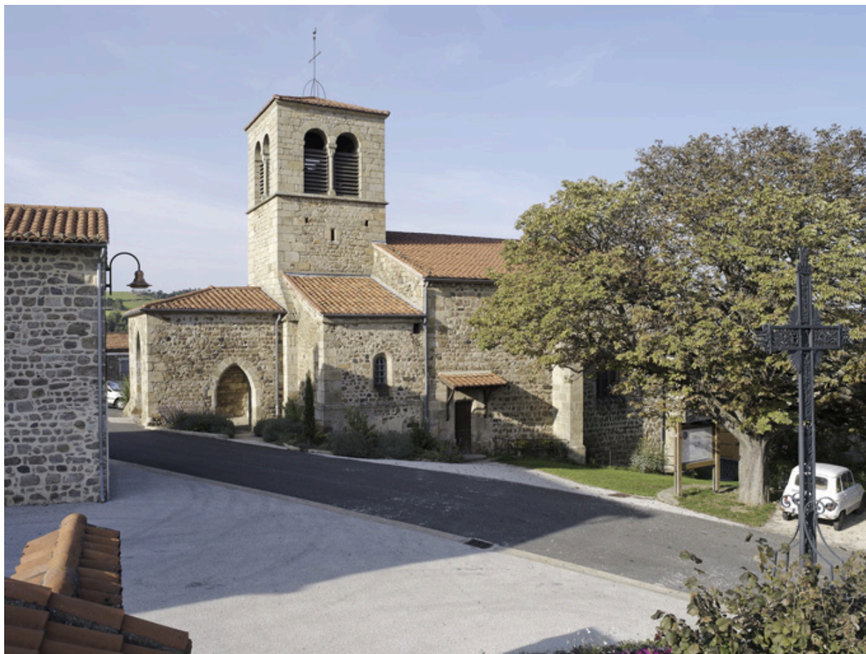
Vue générale depuis le sud.
