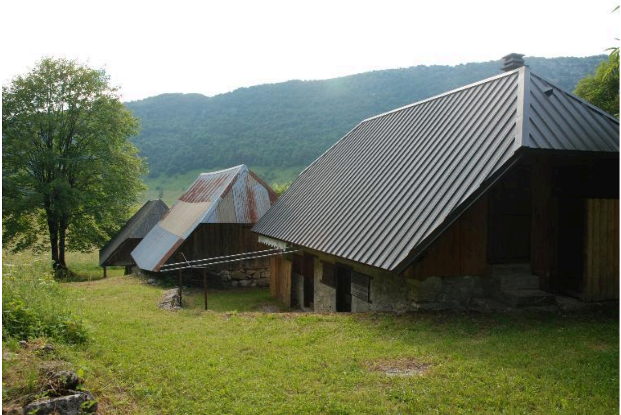
Vue d'ensemble de trois chalets au hameau du Molard (2016 G1 140, IA73004287 et G1 144), depuis l'est : décaissement des élévations arrières.
