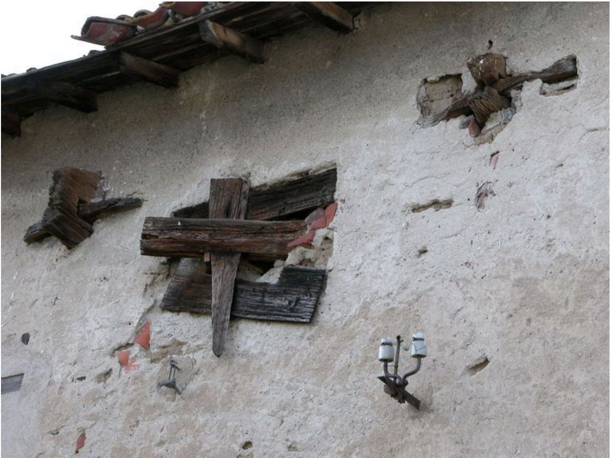
Détail de la clef de serrage en façade sud.
