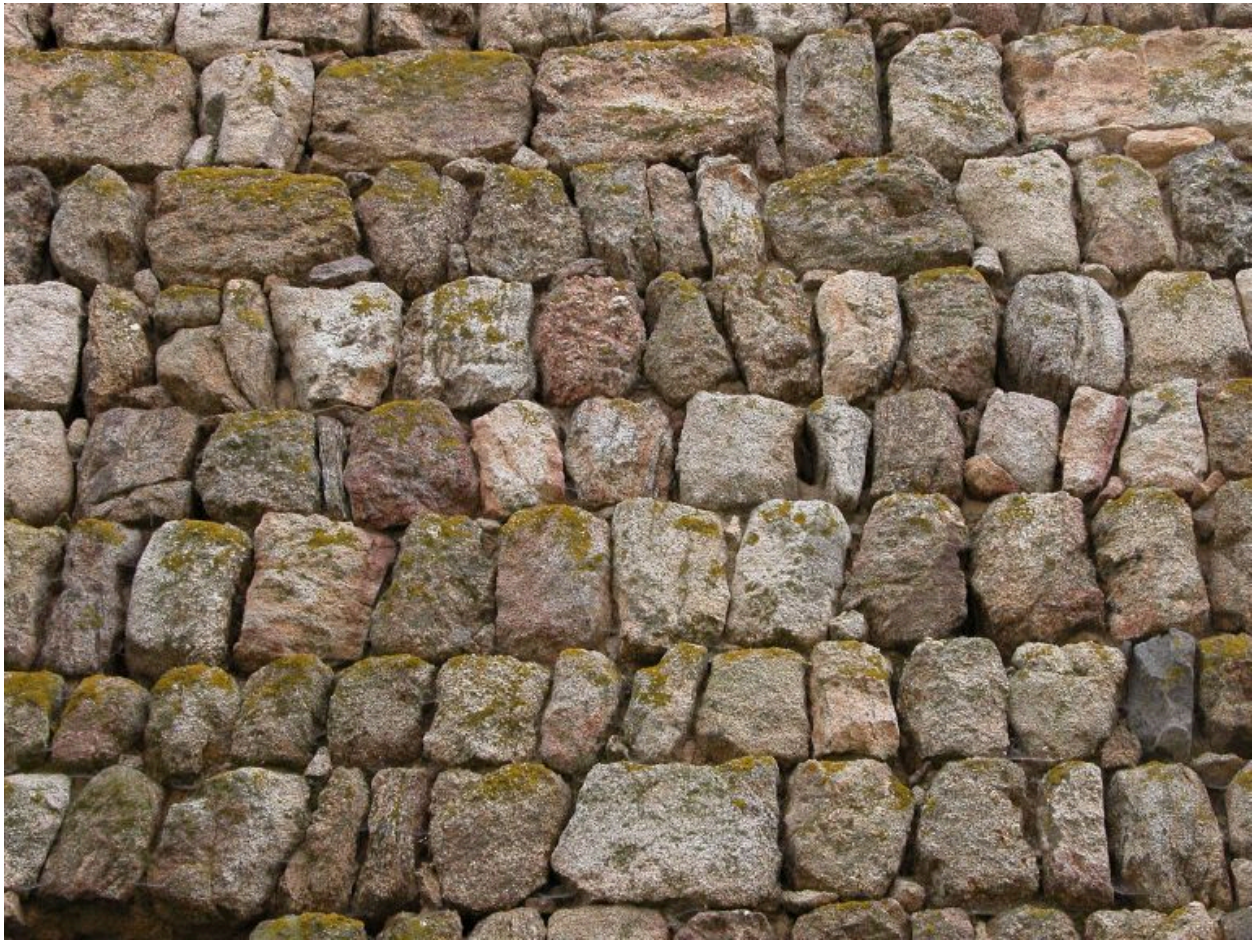
Détail de la mise en oeuvre du mur ouest de la grange-étable nord-ouest : petit moellon sur chant.
