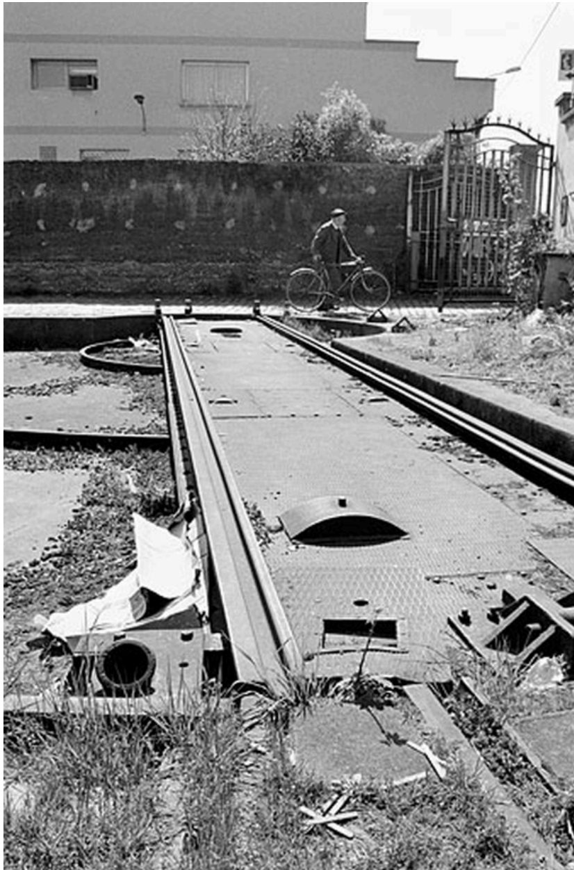
Embranchement ferroviaire : raccordement avec la rue Joannès Carret
