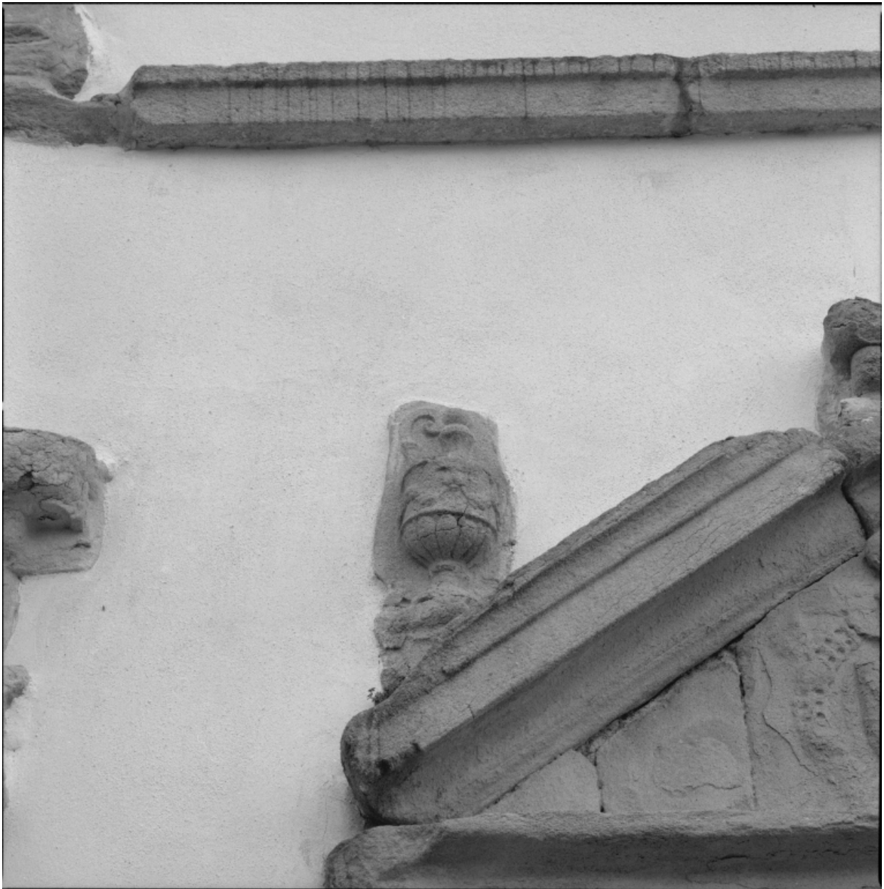
Bastion sud-ouest, porte du rez-de-chaussée ouvrant sur le jardin : détail du pot à feu ornant le fronton.
