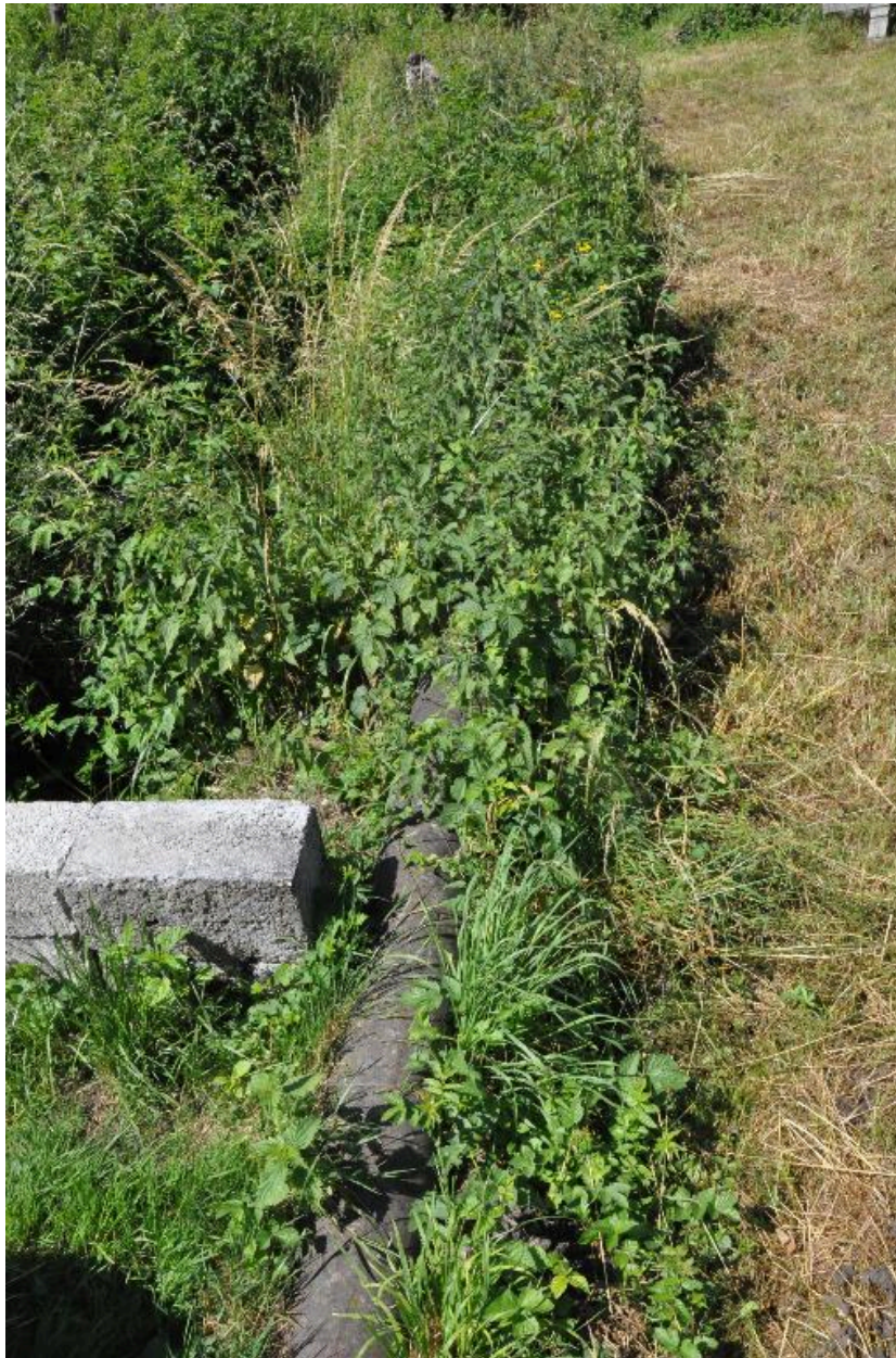
Vue de la conduite forcée au bord de la route départementale.
