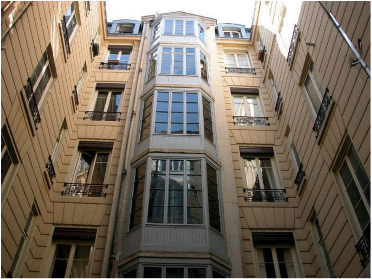
Elévation sud de la cour, partie supérieure
