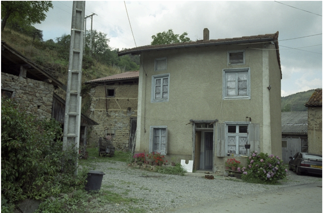
Saint-Laurent-Rochefort, Rivier (1987 A3 1747), type B1. Vue d'ensemble du logis.
