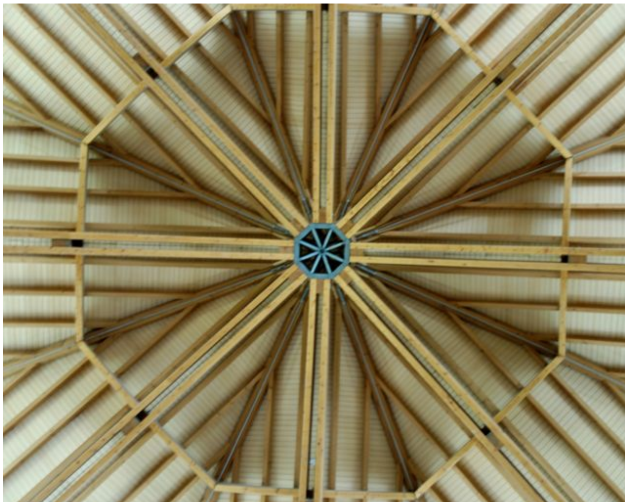
Vue de la charpente de la nef, détail central
