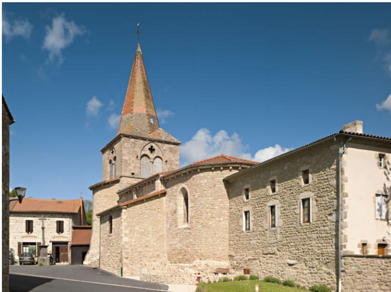
Vue générale coté est.
