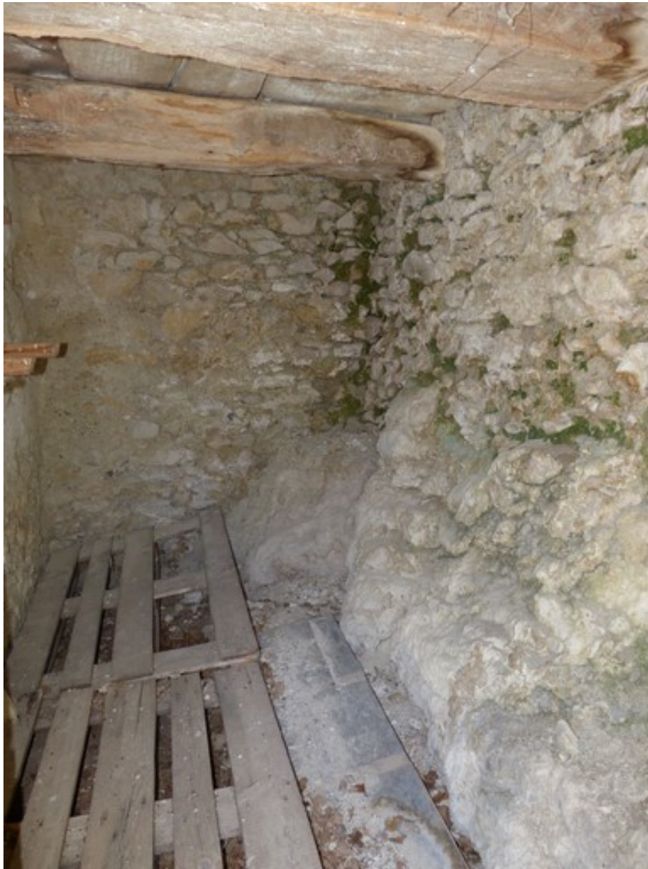
Etage de soubassement, vue de volume prise de l'est.
