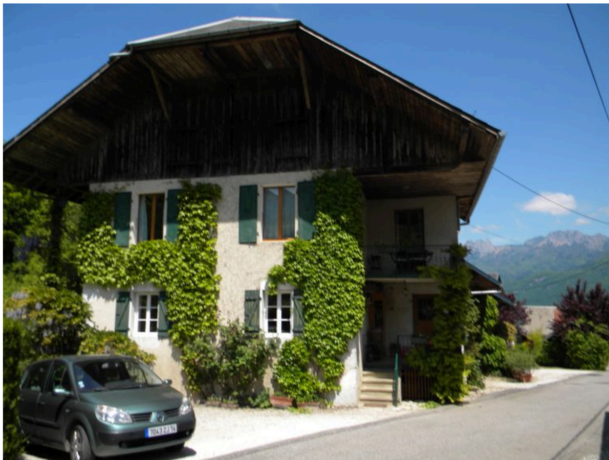
Vue du pignon sud depuis la route de la Bornette.
