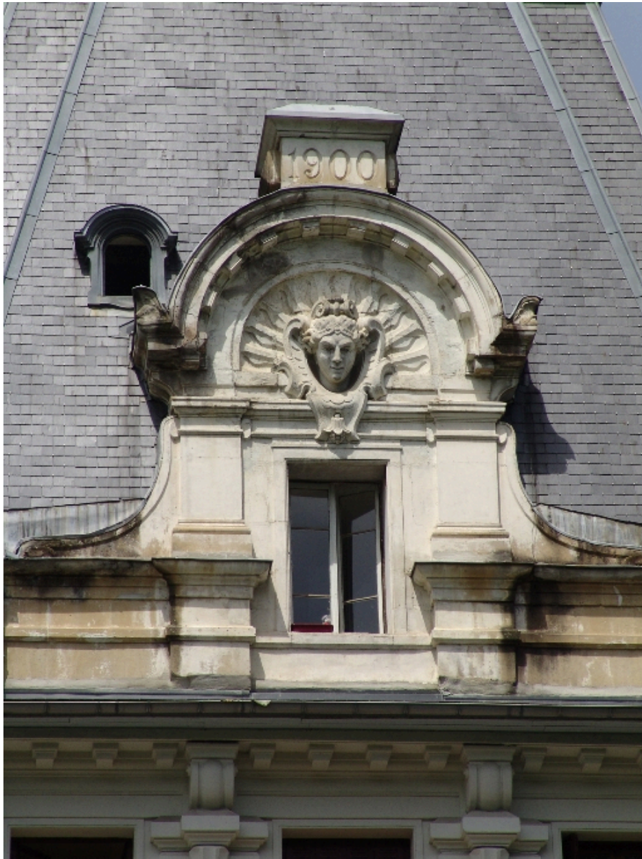
Détail d'une lucarne de l'avant-corps
