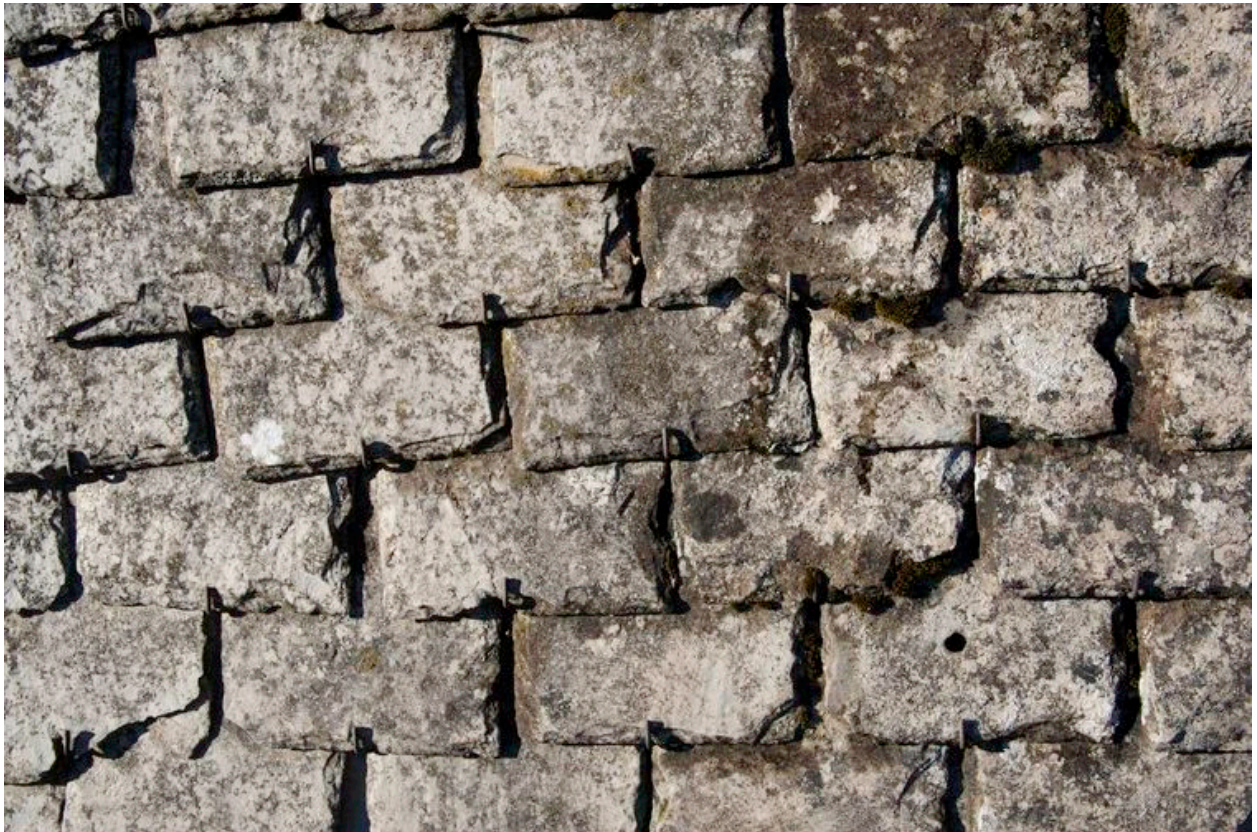
Détail de couverture en ardoise sur la dépendance.
