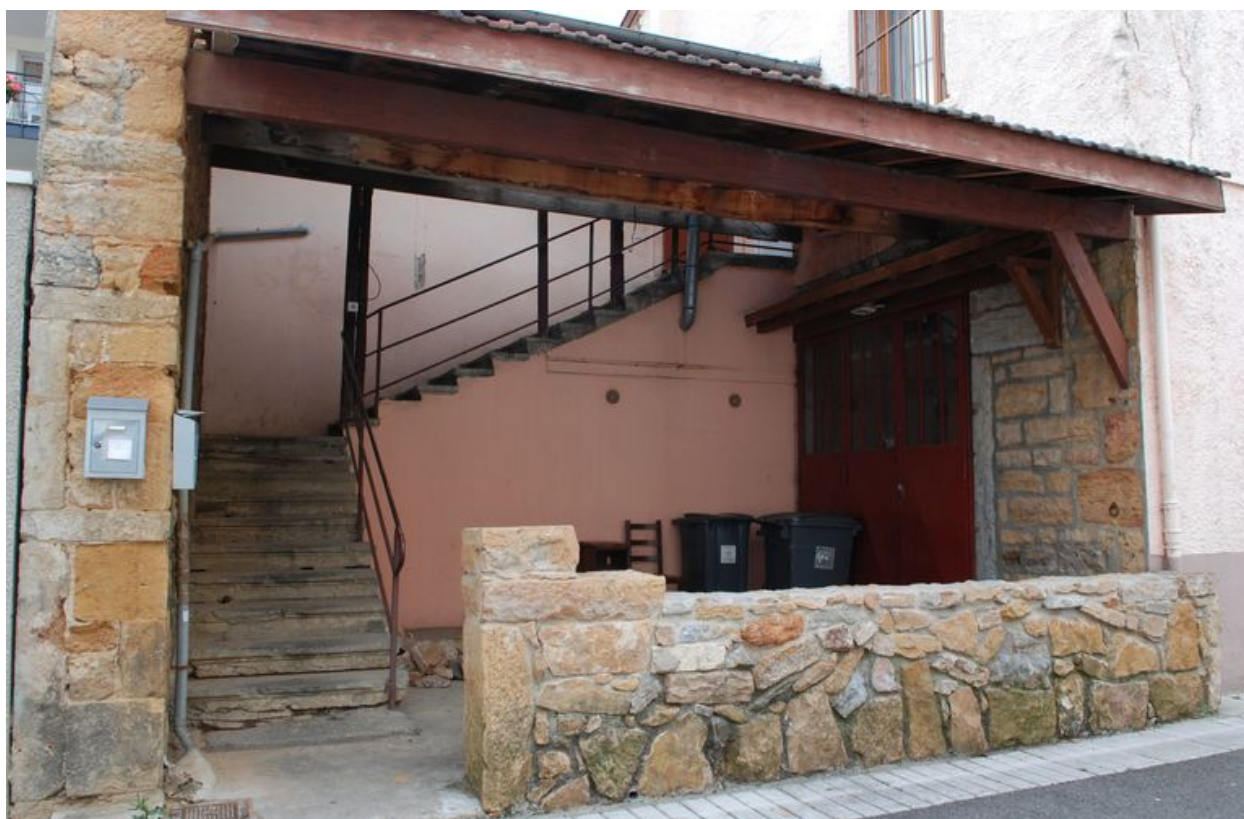
Vue de l'ancienne écurie (?) et de l'escalier extérieur en équerre, situé au nord-est.
