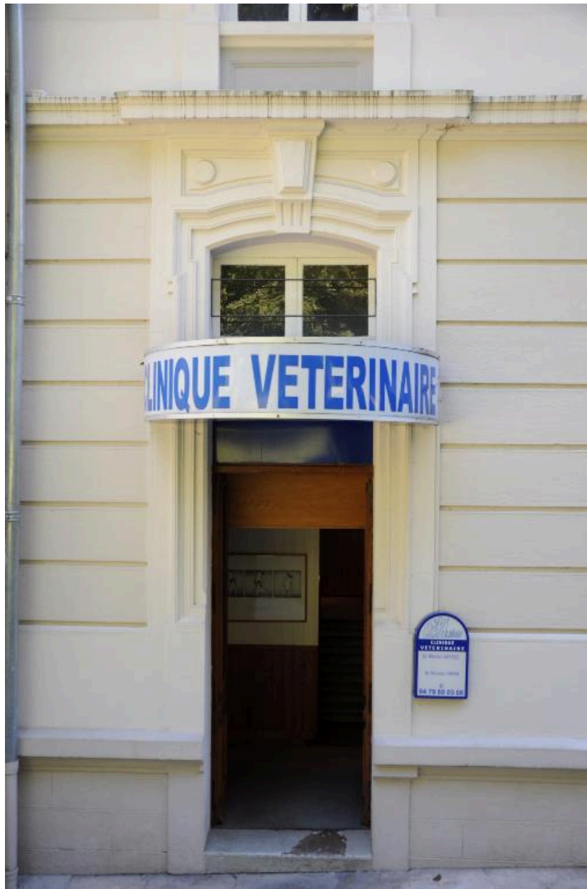
Porte d'entrée sur la façade postérieure (est)
