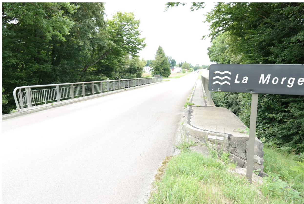
Pont de la Ravoire, chaussée et gardes-corps
