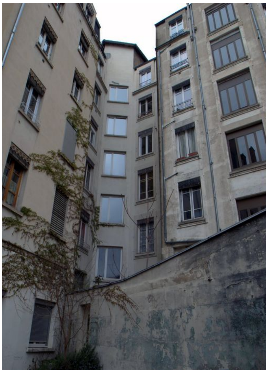
Elévation postérieure ; au centre, la tour d'escalier
