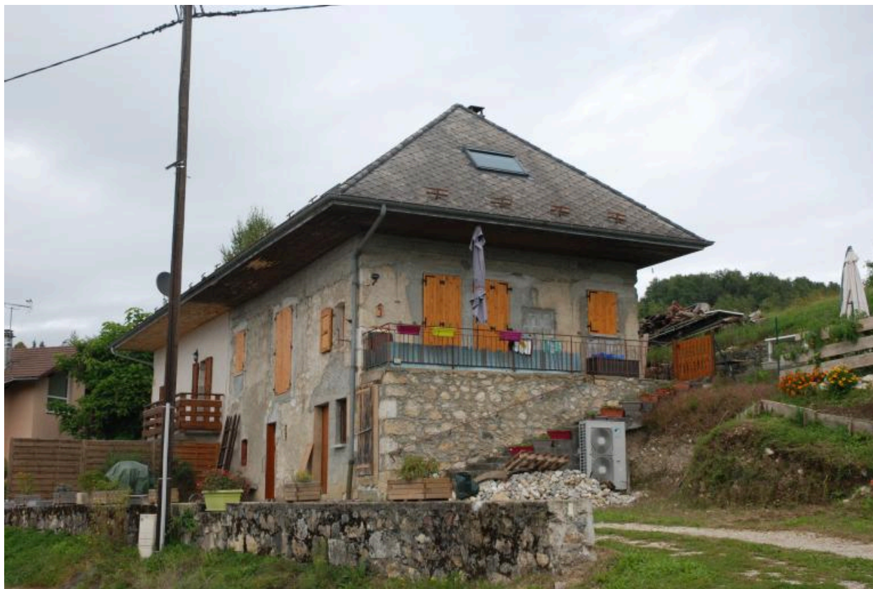
Viuz-Sud, C4 1978. Ferme, actuellement maison. Vue d'ensemble de face.
