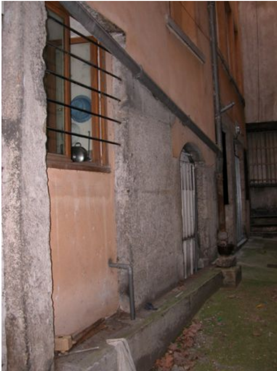
2e corps de bâtiment, élévation sur l'impasse, partie ouest, rez-de-chaussée
