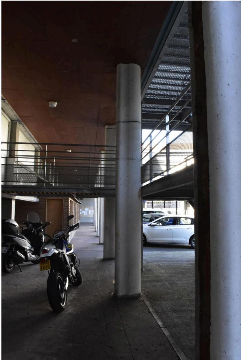
Portique sur le flanc nord du bâtiment principal, menant à couvert du boulevard au degré d'accès au vestibule "d'entrée principale des locaux scolaires". Le sol est d'asphalte rouge, tel que prévu sur les plans d'André Verdier. Les poteaux présentent une section bilobée. La passerelle mène à l'escalier de secours ajouté au 21<sup>e</sup> siècle.
