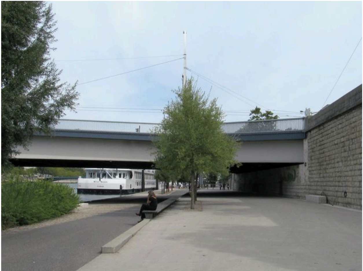
Travée et culée gauche, face aval, vue générale (depuis la rive gauche)
