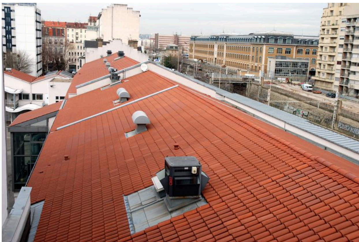
Bâtiments B et C : vue de la toiture
